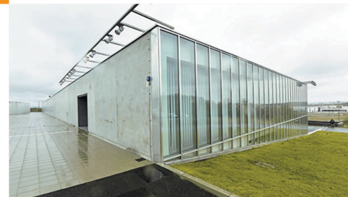
Véritable quartier de haute sécurité, le datacenter est implanté à Peltre (57). Son potentiel régional est aussi dopé par la proximité avec plusieurs frontières.
